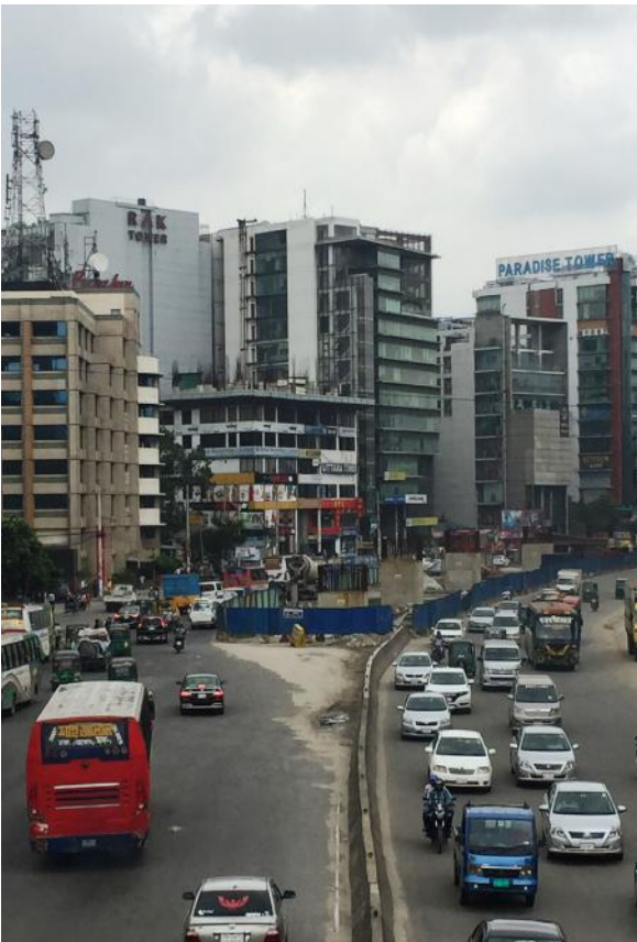
道路の立体化工事が進む首都ダッカ郊外 ＝2019年8月、西尾撮影
